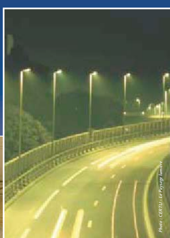
Voie rapide Chaussée Lampe au sodium haute pression 150, 250 ou 400 W
