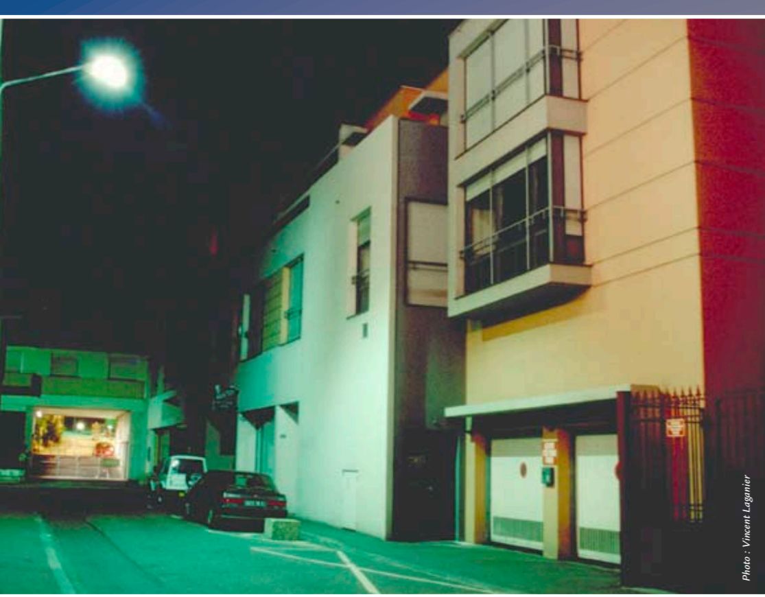
Rue résidentielle Chaussée Ballon fluorescent 125 W Rue des Potiers, Colmar (68)
