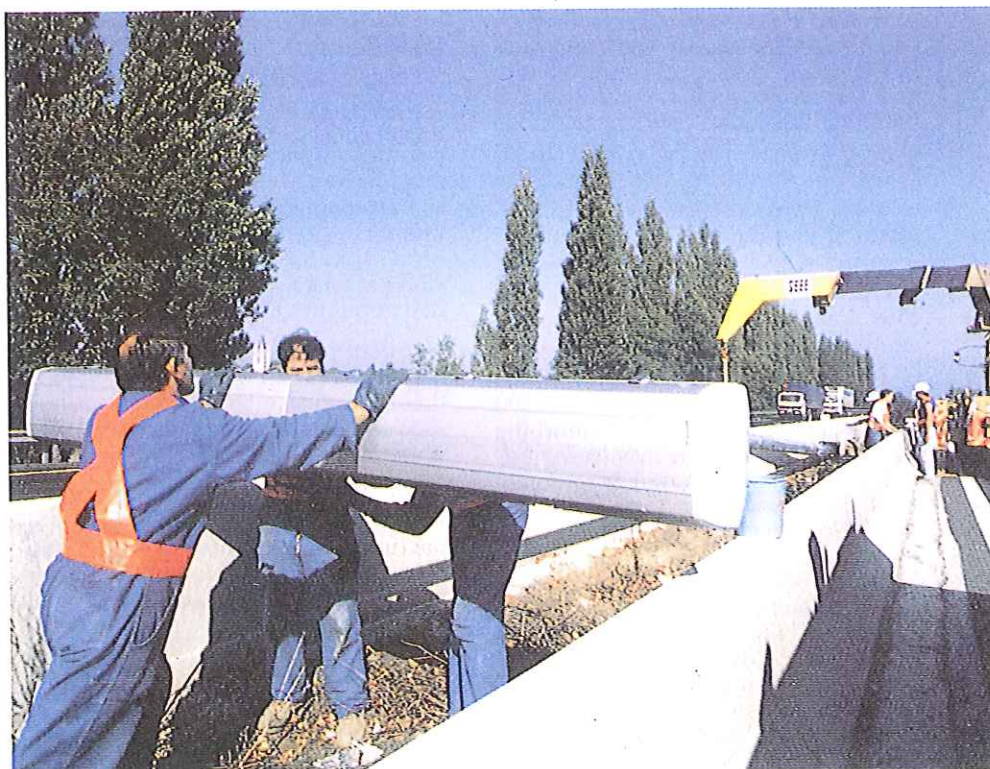
Photo 3. — Carcasse du luminaire à quatre optiques indépendantes et à appareillages incorporés. Poids : 70 kg.
