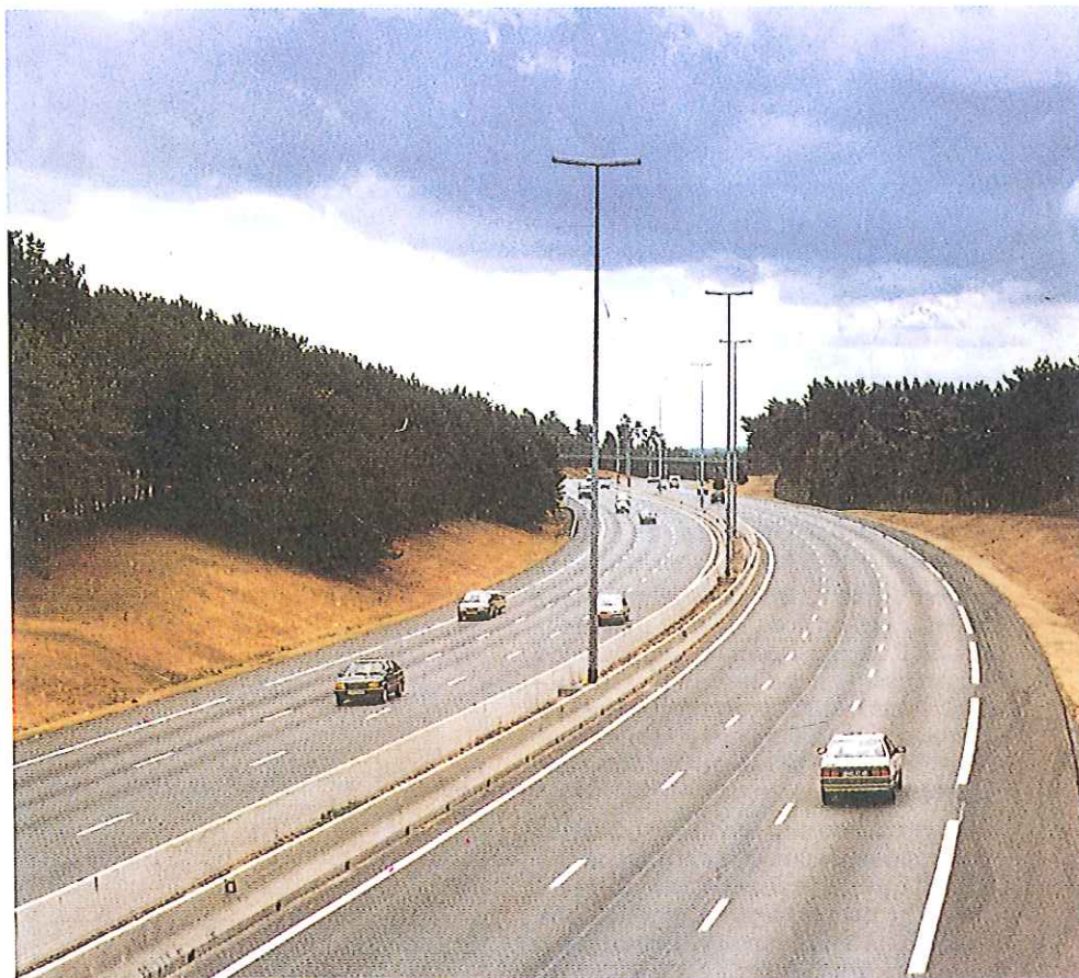
Photo 1. — Autoroute A1 — éclairage en section courante Senlis-Roissy avec des luminaires à quatre miroirs indépendants pour lampes sodium haute pression de 400 W. Les luminaires à appareillages incorporés sont situés à l'extrémité des mâts de 18 m de haut et espacés de 80 m.
